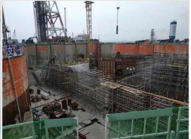
【터널입구 시공 현장】
